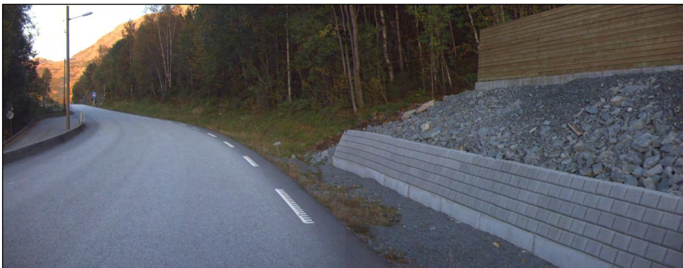
Figur 12 Avkøyrsla mot Strandvegen til venstre har ikkje ei utforming som er i samsvarar med handbok N100 sine krav. Ved framføring av fortau og gang- og sykkelveg må det sikrast tilstrekkeleg sikt (Foto:Viafoto)
