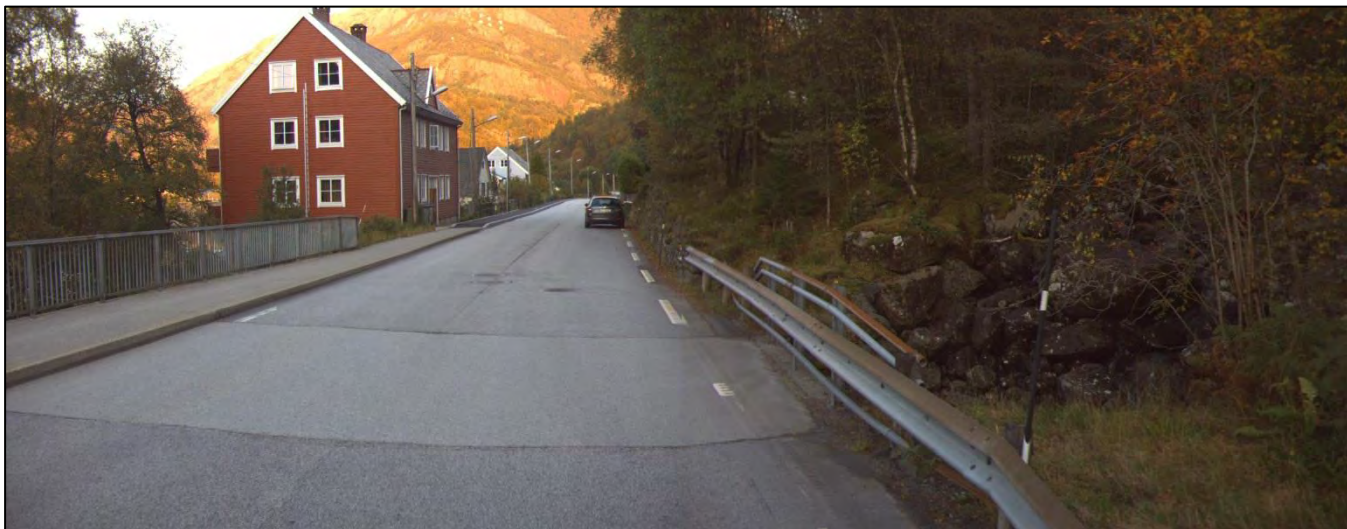
Figur 11 Tiltaket startar der fortauet sluttar i Breivika (Foto:Viafoto)
