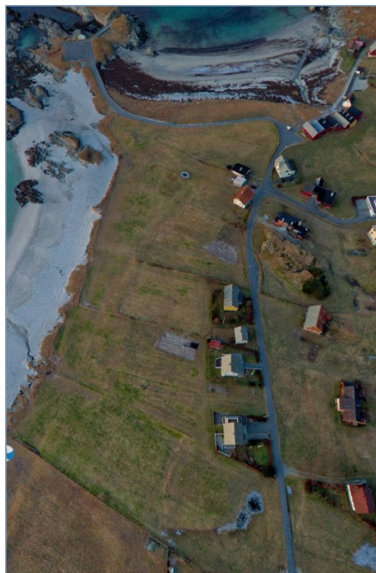
Figur 42: Det etablerte byggemønsteret i området består av at husa på nedsida av vegen ligg inntil fylkesvegen. (foto: Bremanger360).
