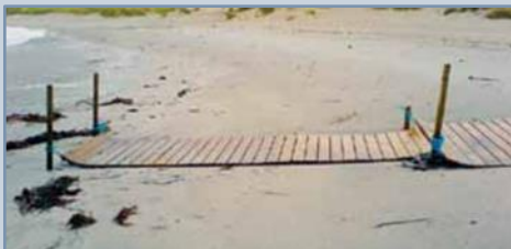
T.v.: Bruk av stolper for å feste trematter slik at dei kan vandre.
