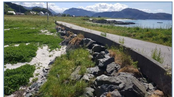
Figur 19: Vegfylling frå Grotlesholmen til fastlandet etablert på 80-talet (Notat Sweco AS)
