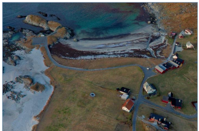
Figur 46: På nordsida av vegfyllinga bygger sanden seg opp. På sørsida av vegfyllinga er det sandflukt. (Foto: Bremanger360).
